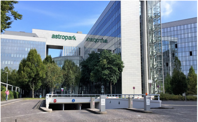
Elaplan-Trainingszentrum im Bürogebäude AstroPark Lyoner Straße 9, Frankfurt am Main - Niederrad
